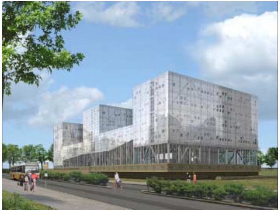
De nieuwbouw vanaf de zonnelaan ©De Zwarte Hond architecten
